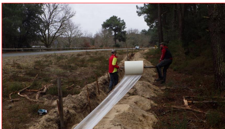
Photo 5 : Mise en place du crapaudrome (credit photo B.Devaux)
