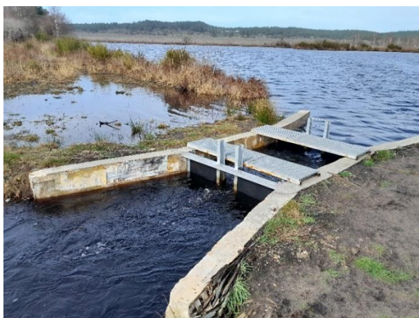
Photo 14 : Ouvrage de Louley en fonctionnement (Crédit photo A. Pellé)
